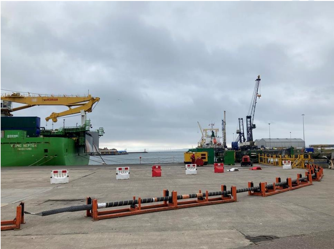
Chargement du câble dans le navire Viking Neptun
