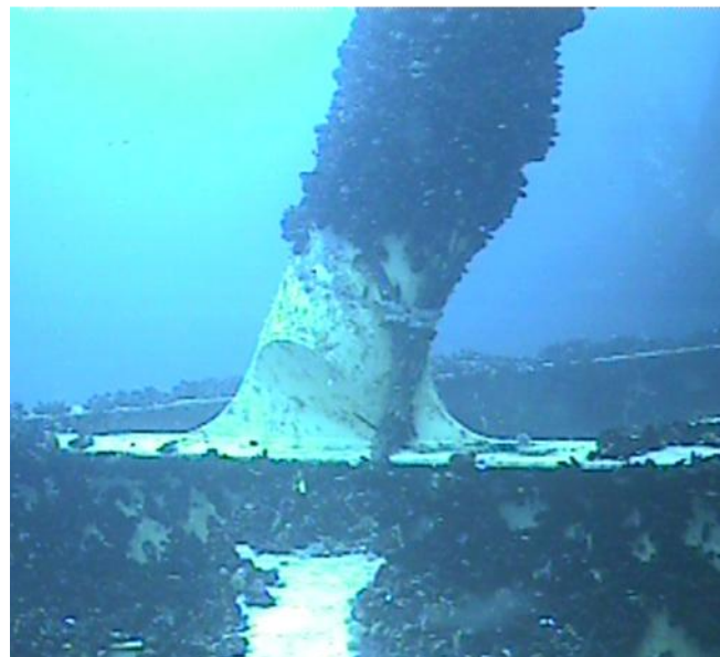
Présence de moules sur le flotteur du prototype WindFloat 1 (source : PPI)
